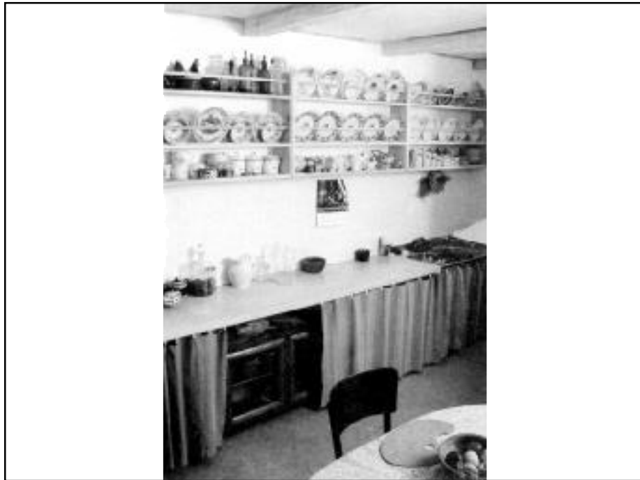
Rys. 5.14-43. Przykład kuchni bez szafek systemowych. Błat oparty na metalowych wspornikach zamocowanych w ścianie, pod nim półki i szafki za zastonką [9]
